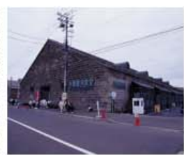
▲小樽運河地区の一角にある「小樽運河食堂」。古い巨大倉庫を改造した館内に全国から集まった有名ラーメン店が6店と、バイク方式でジンギスカンや地ビールなどが楽しめるビアホールがある。営業時間／11:00-0:00 料金／入場無料
